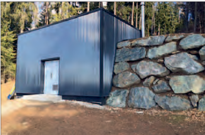
Hochbehälter bei vlg. Friesacher
