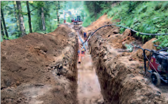
EWVA Pontnig Bauarbeiten
