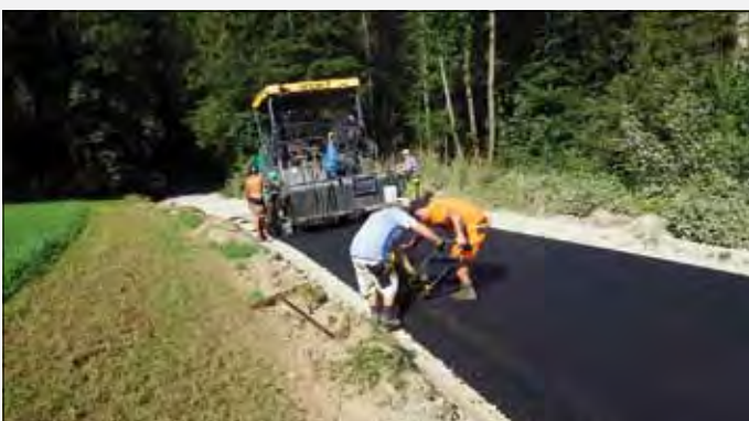
Findenig Straße – Durchfräßmethode, Unterbau – Asphaltierung
