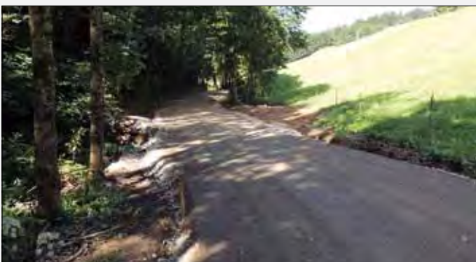
Findenig Straße – Durchfräßmethode, Unterbau – Asphaltierung
