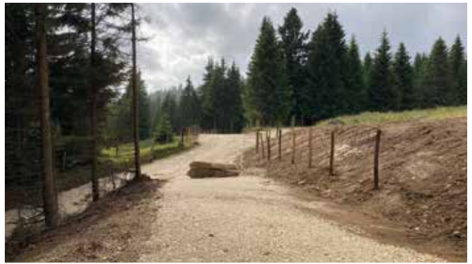
Wegverlegung im Bereich Steinberg-Gundischer Alm
