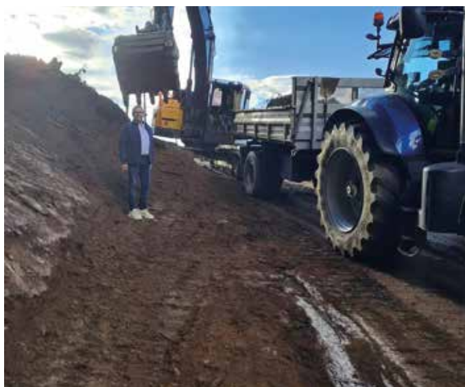
Ausbau der Steinberger Straße
